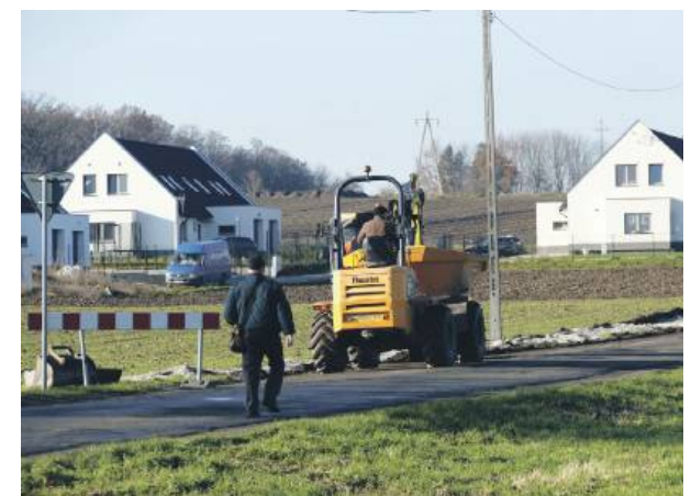
Niedawno ruszyły prace związane z przebudową ul. Siemysławickiej w Przewornie
