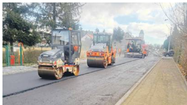
Wylano już warstwę wiążącą na odcinku Biały Kościół – Gębczyce. Fot. PZD w Strzelinie
