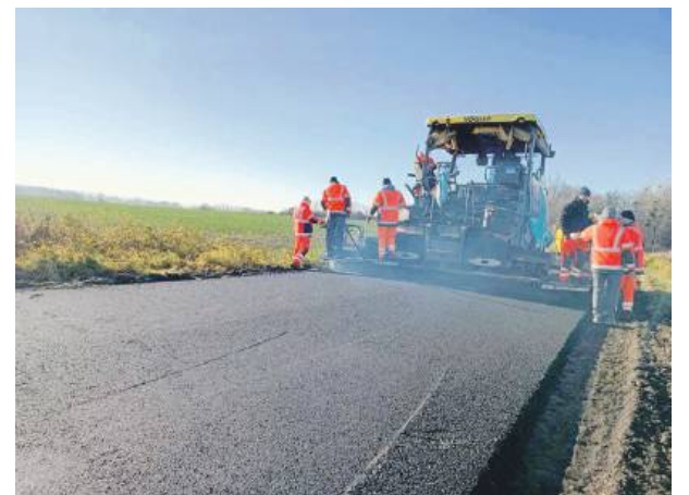
W poniedziałek i wtorek, 2 i 3 grudnia, na całej szerokości jezdni układana była nawierzchnia asfaltowa. Fot. PZD w Strzelinie
