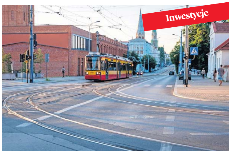
Remont torowiska w rejonie pl. Reymonta ma potrwać 2,5 miesiąca.
