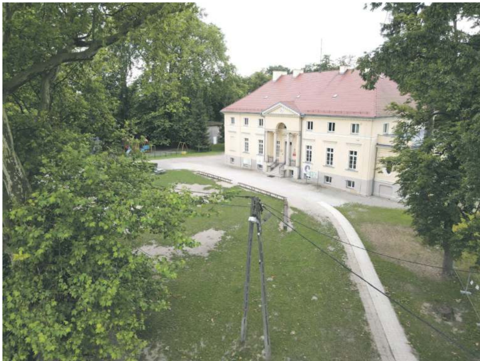
Szkoła mieści się w zabytkowym budynku
