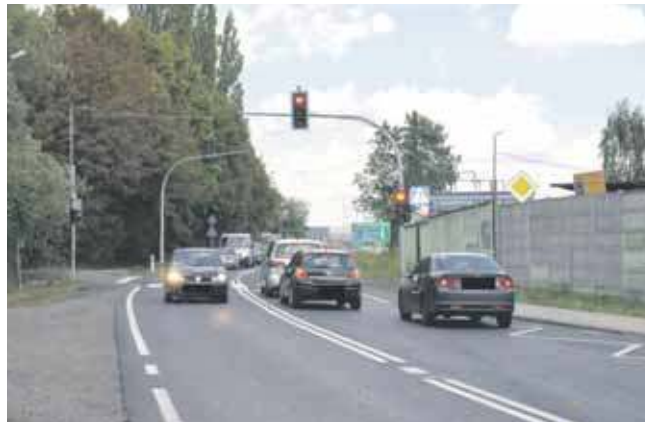
Rondo na skrzyżowaniu powiatowej ul. Ziemieckiej i krajowej ul. Tarnogórskiej (nr 78) ma być gotowe w połowie przyszłego roku
