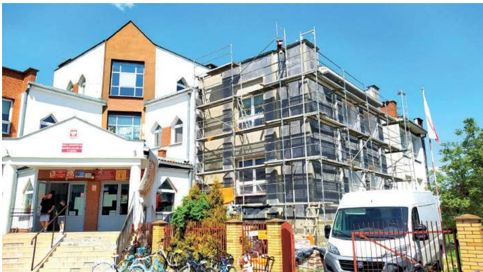
Projekt „Termomodernizacja Szkoły Podstawowej nr 4 w Łęcznej” otrzymał dofinansowanie z Rządowego Funduszu Polski Ład Program Inwestycji Strategicznych w wysokości 7,2 mln zł. Całkowity koszt robót budowlanych 11,5 mln zł
