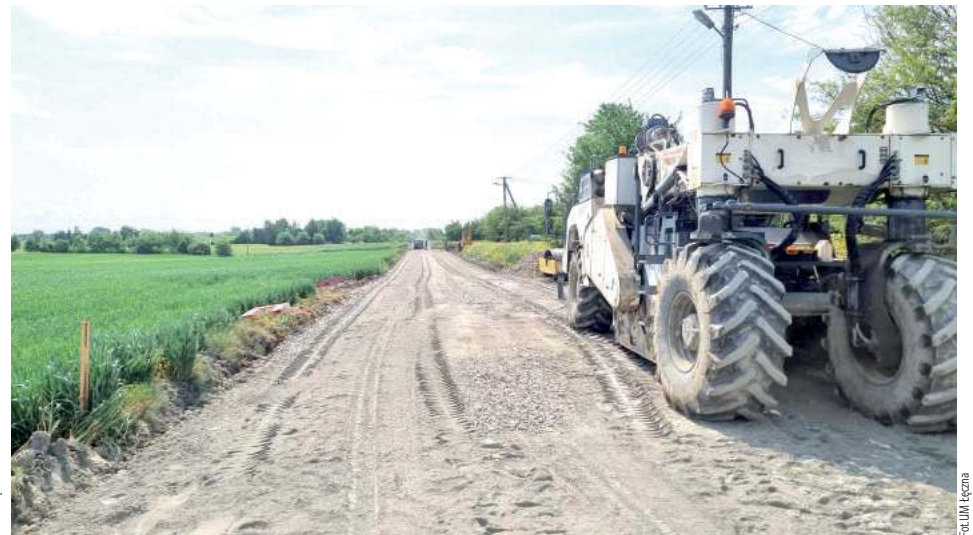
Roboty na drodze nr 105192L w Trębaczowie. Wykonawcą jest PRD Lubartów S.A. Koszt to 638 tys. zł, finisz prac w sierpniu br.
