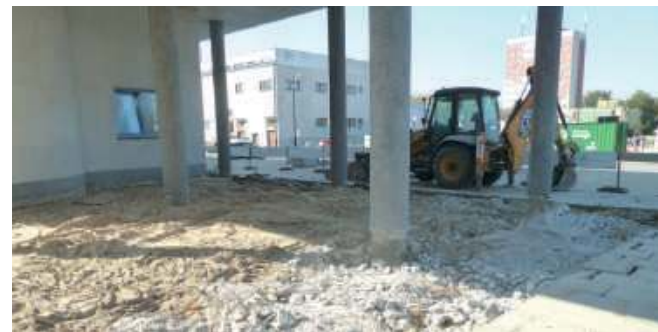
Prace są prowadzone na tyłach urzędu, w tzw. podcieniach od strony Placu Chopina
