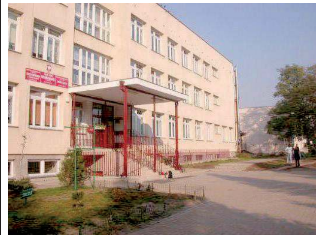
Gmina pozyskała środki na termomodernizację Zespołu Szkolno - Przedszkolnego w Baranowie. W przyszłym roku budynek będzie wyglądał zupełnie inaczej
