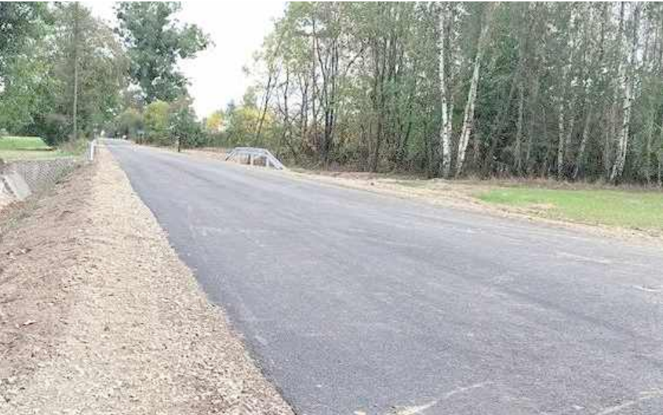
Aż miło popatrzeć na nowy asfalt
