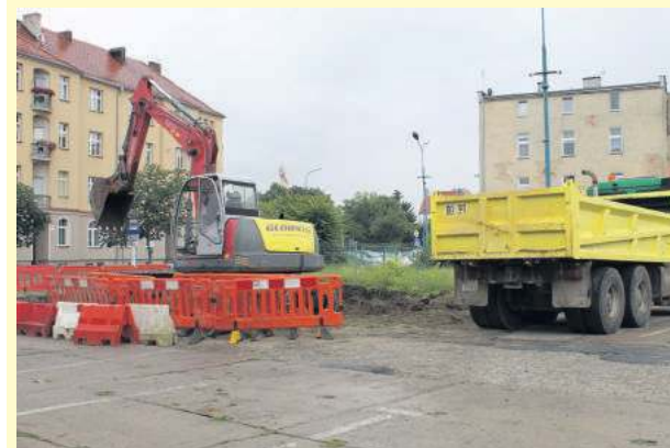
Prace związane z przebudową strzeleńskiego dworca autobusowego powinny zostać wykonane do końca września br.
