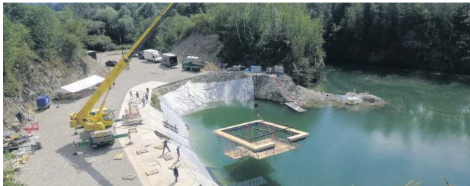
W Przewornie trwają prace związane z rozbudową bazy dla nurków. Foto: Projekt Kamieniołom
