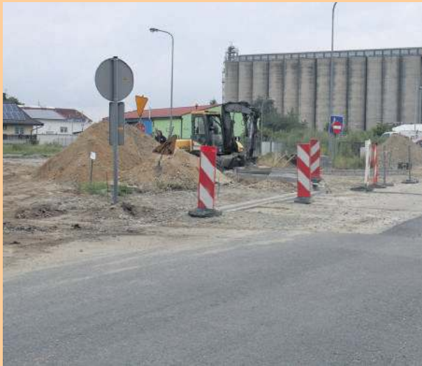
Mimo początkowych trudności, wznowiono prace przy przebudowie ulicy Energetyków w Strzelinie
