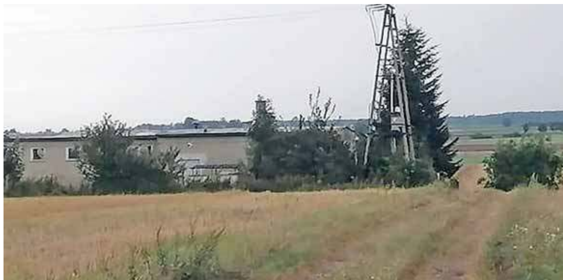
Ujęcie wody w Kałęczynie (gm. Gołymín Ośrodek)
