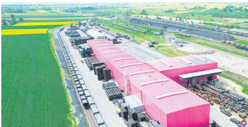
Obiekt przejmie sporą część ładunków przechodzących z Ukrainy do Polski.
