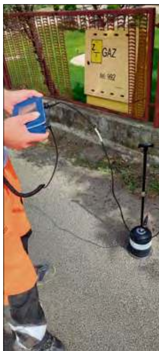
Dzięki geofonom pracownicy firmy Plada są w stanie precyzyjnie lokalizować miejsca wycieków.
