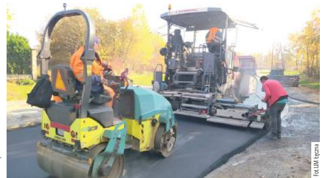
Projekt „Budowa sieci dróg gminnych w Łęcznej” - całkowity koszt inwestycji to 3.379.869,23 zł, dofinansowanie w wysokości 95 proc. pochodzi z Rządowego Funduszu Polski Ład Program Inwestycji Strategicznych
