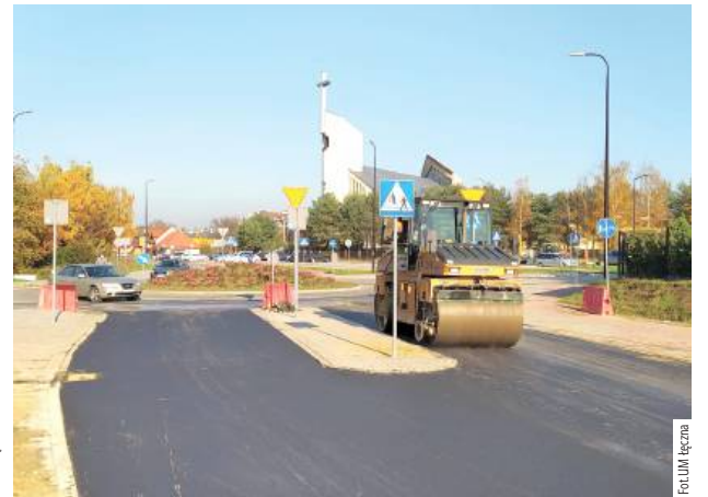
Porządna nawierzchnia na nowych drogach już gotowa
