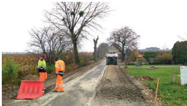
Projekt drogowy gm. Łęczna „Przebudowa drogi gminnej nr 105177L w Podzamczu i Witaniowie” został dofinansowany z Rządowego Funduszu Rozwoju Dróg kwotą 1.461.760,96 zł. Całkowita wartość inwestycji to 3.449.171,73 zł
