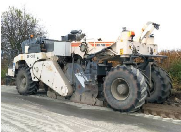
Od ub. tygodnia na placu budowy pracuje recykler
