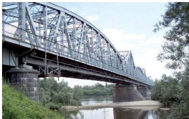
Remont ma poprawić stan mostu i zwiększyć bezpieczeństwo dla korzystających z przeprawy. Podczas wykonywania prac most zostanie całkowicie zamknięty dla ruchu samochodowego
