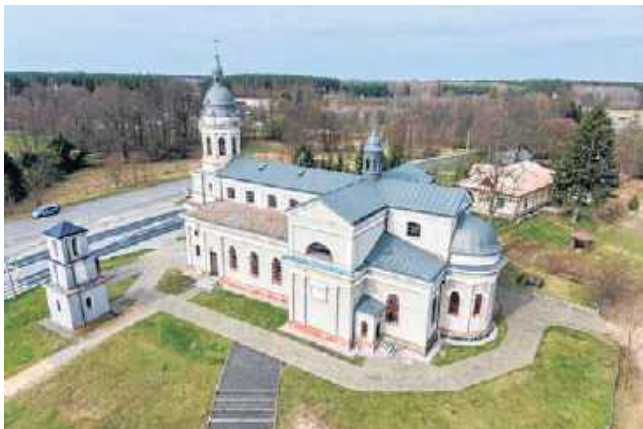
Remont dachu i poszycia dachowego w kościele w Suchej w gminie Pionki kosztował 400 tysięcy złotych.
