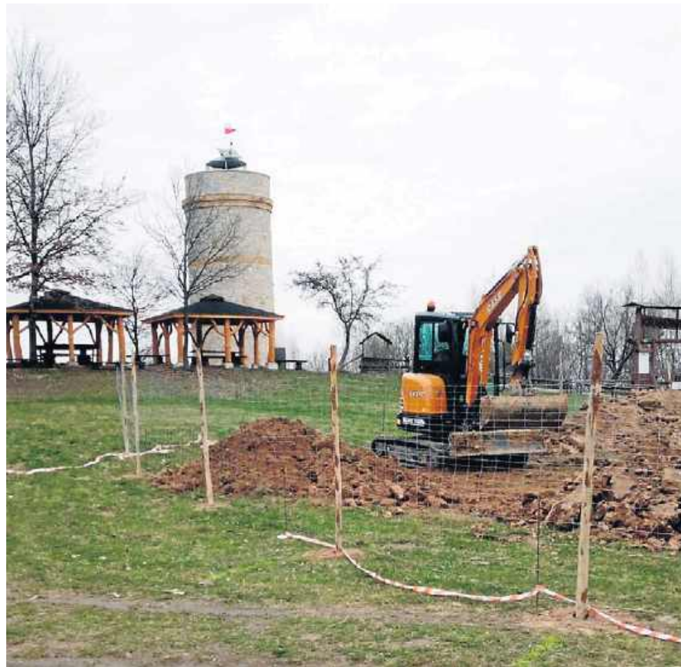
Zaczęły się wykopy na Krakowej Górze w Borkowicach, gdzie stanie leśny amfiteatr.
