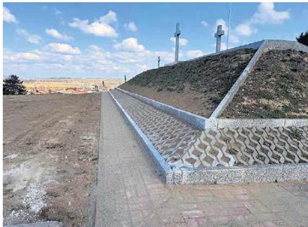
Zakres prac obejmował końcowy etap zagospodarowania terenu wokół mogiły
