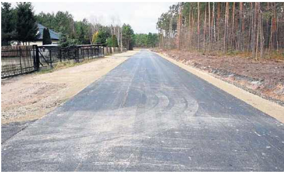
Trwa budowa nowej drogi w Marzyszu o długości ponad 300 metrów
