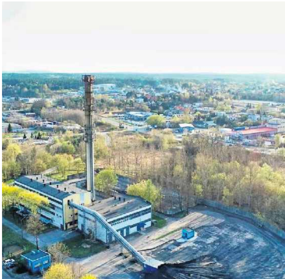
Co dalej z budową Instalacji Odzysku Energii w Starachowicach?
