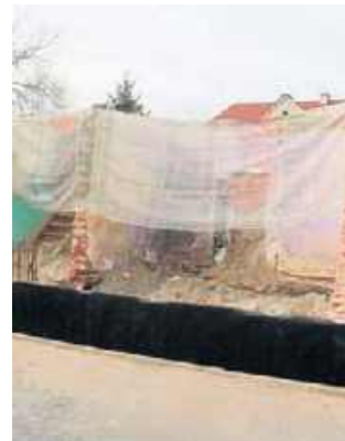
Budynek został niemal w całości rozebrany.
