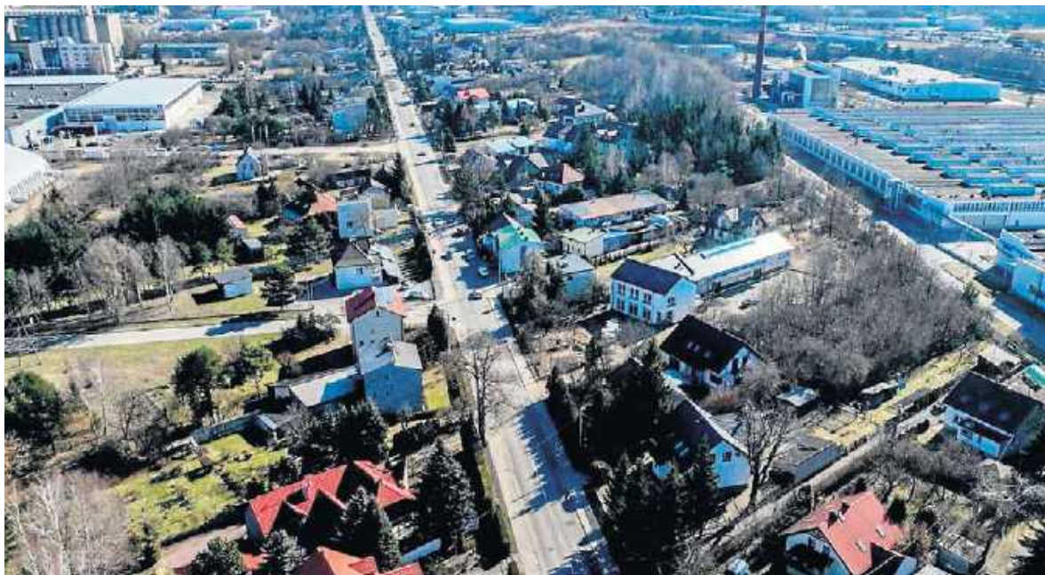
Na Batalionów Chłopskich remontowany będzie niemal kilometr odcinek między ulicami Malików a Zakładową
