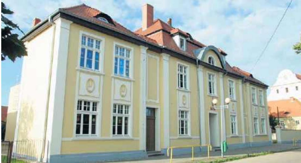
Modernizacja budynku ZOL w Wągrowcu dobiega końca.
