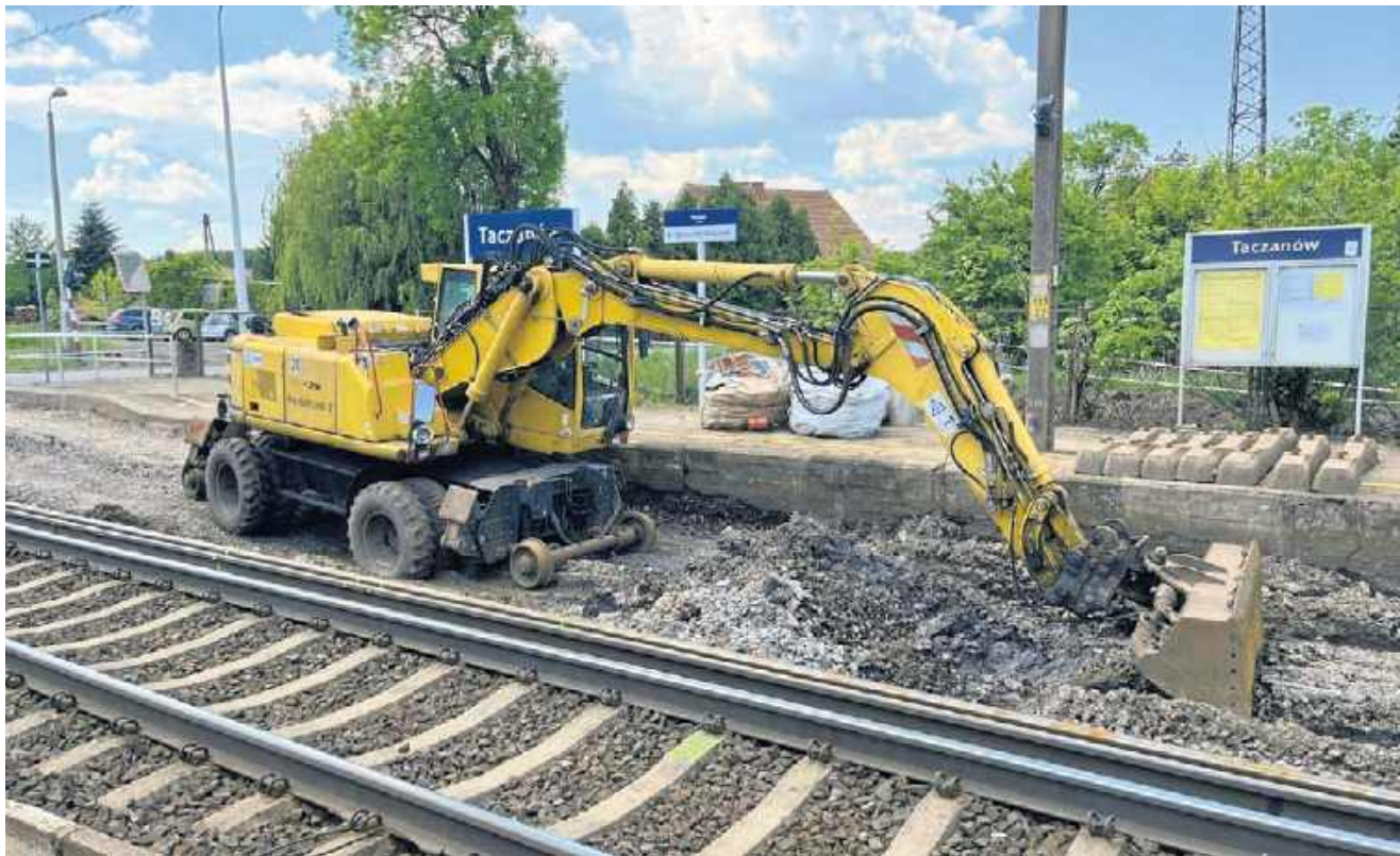
Po dworcu PKP pora na remont torowiska.
