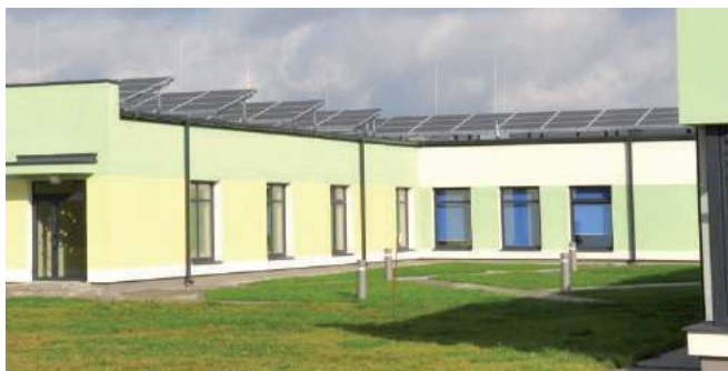
Nowa i nowoczesna siedziba Szkoły Filialnej w Świerszczowie wyposażona w: instalację elektryczną wykorzystującą alternatywne źródła energii w postaci ogniw fotowoltaicznych na dachu, wodociągową opartą na układzie solarnym wspomagany układem powietrznych pomp ciepłych. Na dachu budynku od południa pracuje pięć kolektorów słonecznych. Jest centralne ogrzewanie podłogowe z dwiema pompami ciepła powietrze-woda. Koszt inwestycji to 6 mln zł. Szkoła otwarta została 15 listopada 2019 roku
