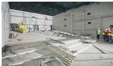
Sala kinowa w remoncie
