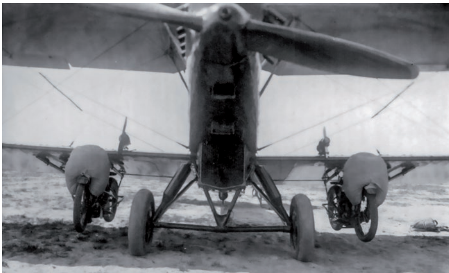
▲ Samolot rozpoznawczo-bombowy R-5 z 3. Brygady Lotniczej Specjalnego Przeznaczenia z podwieszonymi dwoma motocyklami. Pojazdy są w części osłonięte pojemnikami ze spadochronami, które chociaż częściowo zmniejszały opór aerodynamiczny. Na górnej powierzchni dolnych skrzydeł widać prądnice wiatrowe.
