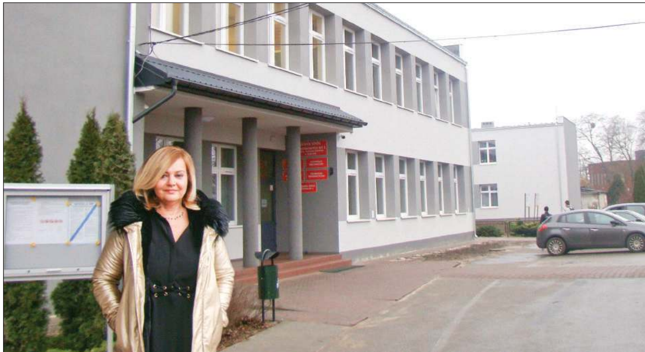
■ Dyrektor Jolanta Kiebzak nie kryje zadowolenia z przeprowadzonego remontu. - Mam nadzieję, że to przyczyni się zmniejszenia kosztów związanych z prowadzeniem budynków - wyjaśnia
