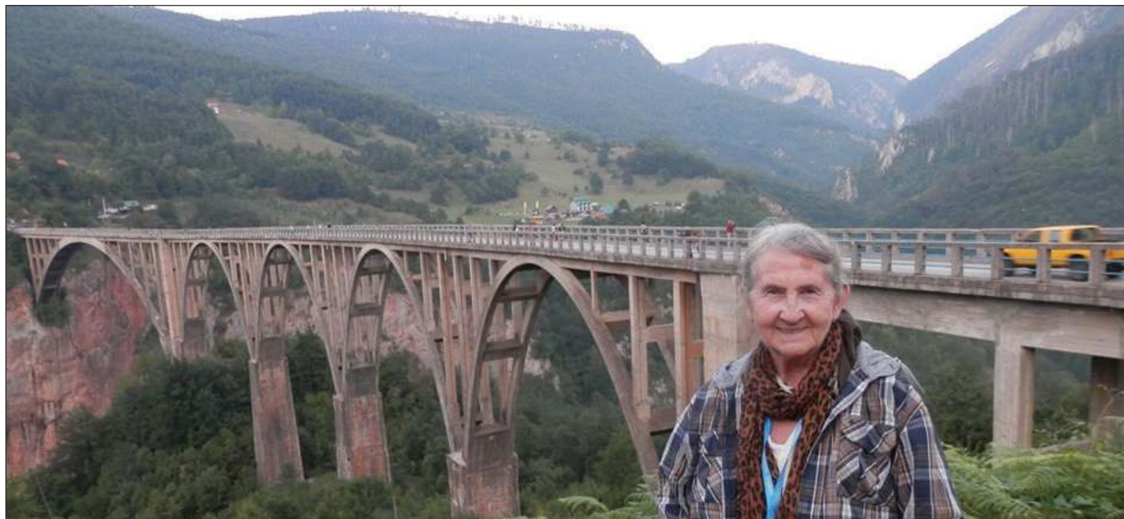
Podróżniczka przy moście na rzece Tara w Czarnogórze. - Wyjątkowo malowniczy widok. Most łączy oddalone od siebie o prawie 400 m dwie ściany wąwozu i wznosi się pięciotukową konstrukcją na wysokość 150 m - wyjaśnia
