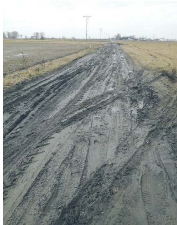
Ulica Wspólna - część nieutwardzona, która będzie remontowana
