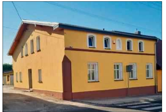
Kolejny gminny obiekt został zmodernizowany.
