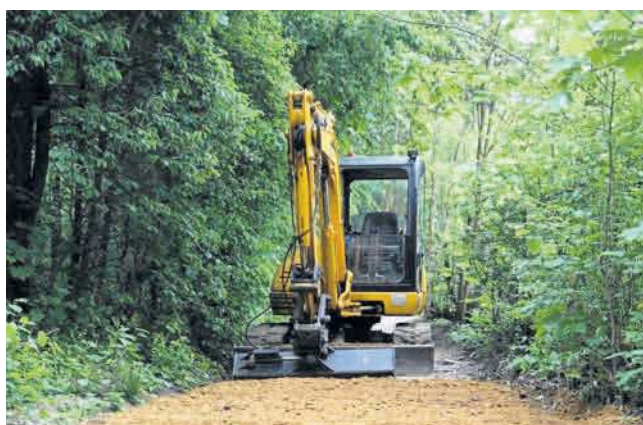
Remontowane ścieżki są wysypywane tylko kamieniem naturalnym
