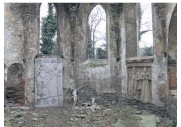
Ruiny kościoła ewangelickiego w Miechowicach Oławskich zostaną zabezpieczone dzięki dotacji od Dolnośląskiego Wojewódzkiego Konserwatora Zabytków. Na zdjęciu wnętrze ruin, w których zachowały się oryginalne płaskorzeźby
