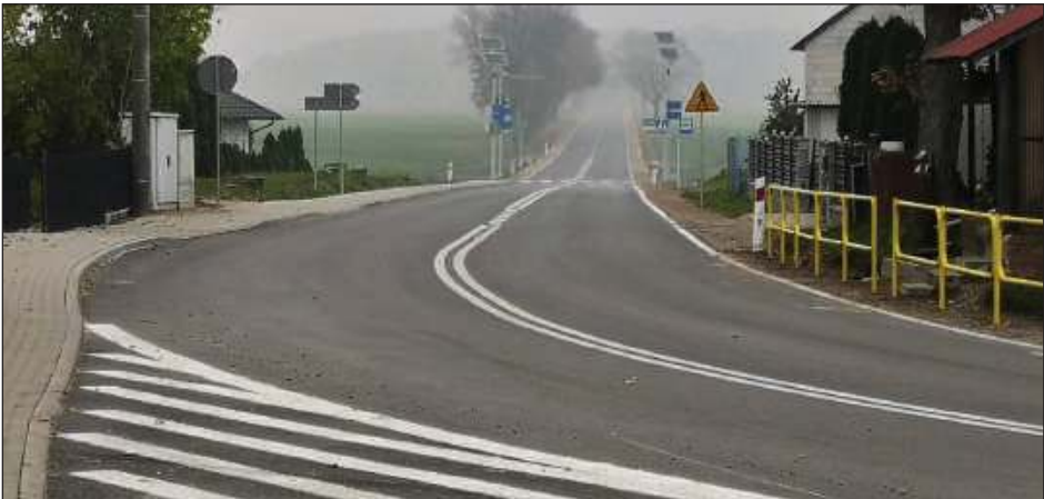
➤ Po modernizacji droga w Dudkach jest nieco szersza, niż dotychczas i zdecydowanie bardziej bezpieczna
