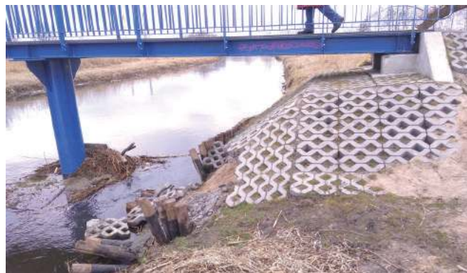
Szpetnie i niechlujnie wygląda okolica nowej kładki
