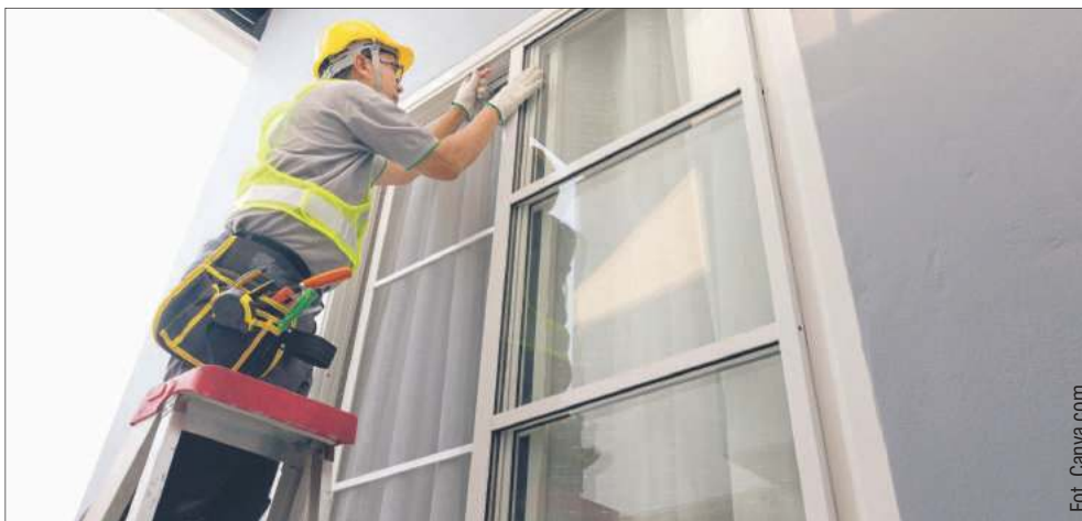
W nowym programie można zdobyć środki m.in. na wymianę okien. Sprawdź, na co jeszcze.
