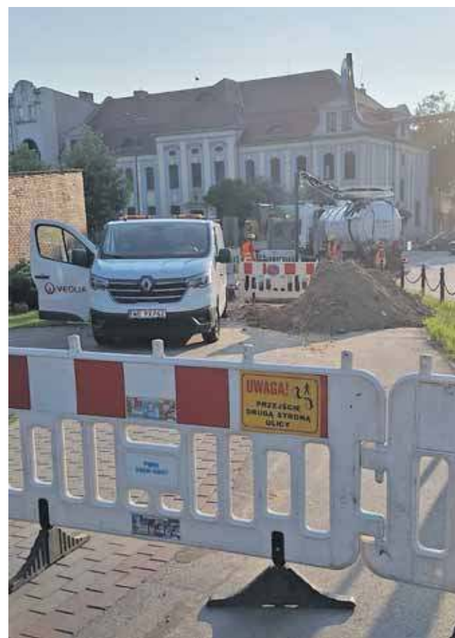
Jednym z kluczowych zadań zrealizowanych w ostatnim czasie była modernizacja infrastruktury w samym sercu miasta – w rejonie Hali Targowej
