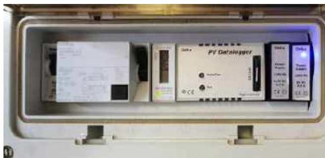
Rysunek 1. Gotowy rejestrator energii z licznikiem i zasilaczami, zainstalowany w małej plastikowej skrzynce rozdzielczej
