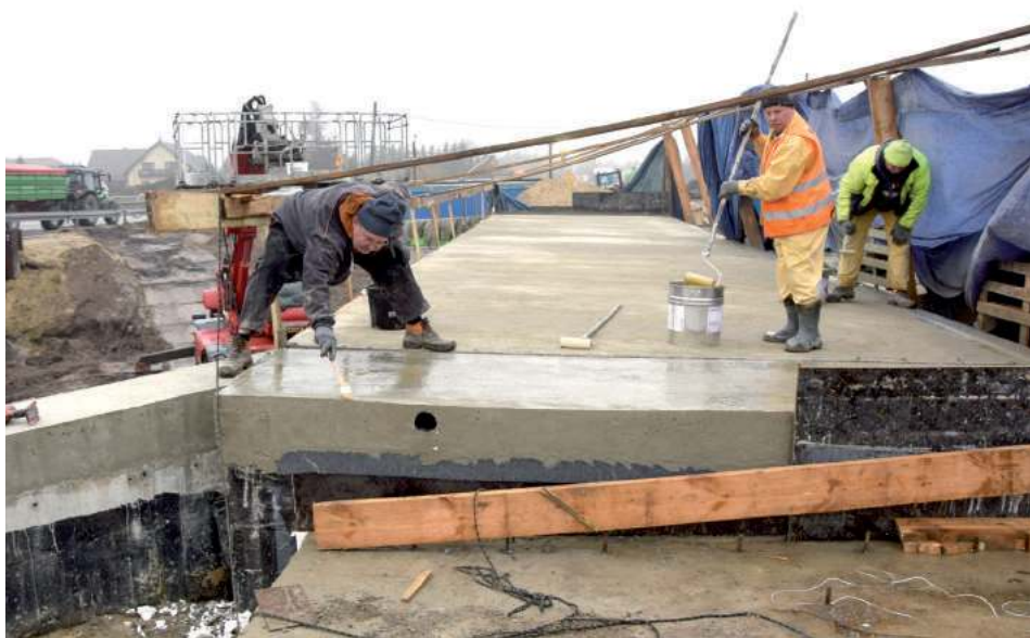
Na kanale Wieprz-Krzna powstaje 13-metrowy most. Na czas jego budowy kierowcy poruszają się po tymczasowej przeprawie, która powstała jesienią
