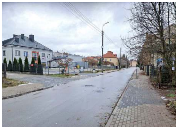
Jeden z progów ma zostać zamontowany przed ŁOK (fot. Patryk Pytlak)
