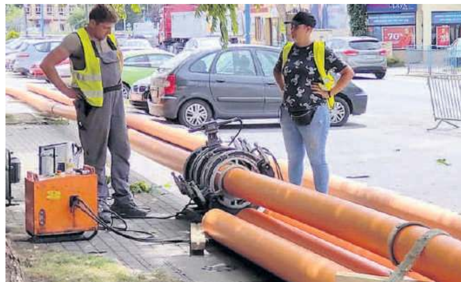
W ubiegłym tygodniu ruszyły prace związane z kompleksową modernizacją ulicy Wolności w Strzelinie
