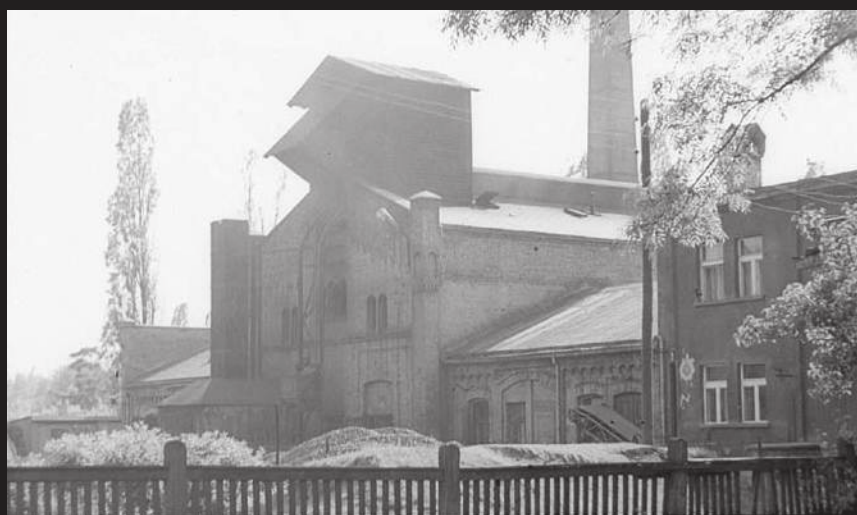
1968. Gazownia miejska - widok od strony miasta
