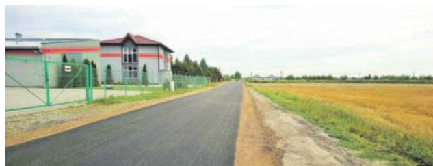
Nowa droga gotowa. Tak wygląda ulica Szmaragdowa
