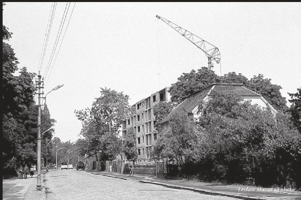
1967. Ulica 1 Maja - budowa bloku
