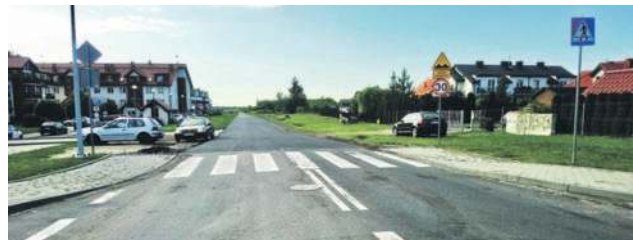
Nowa nawierzchnia na ul. Południowej
