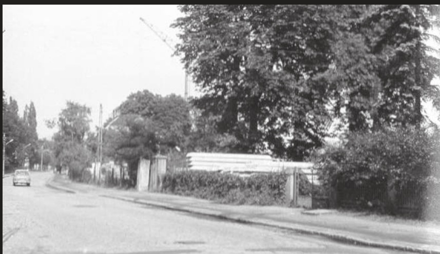
1970. Ulica 1 Maja w kierunku do miasta, naprzeciw gazowni, trwają przygotowania do budowy domu mieszkalnego
