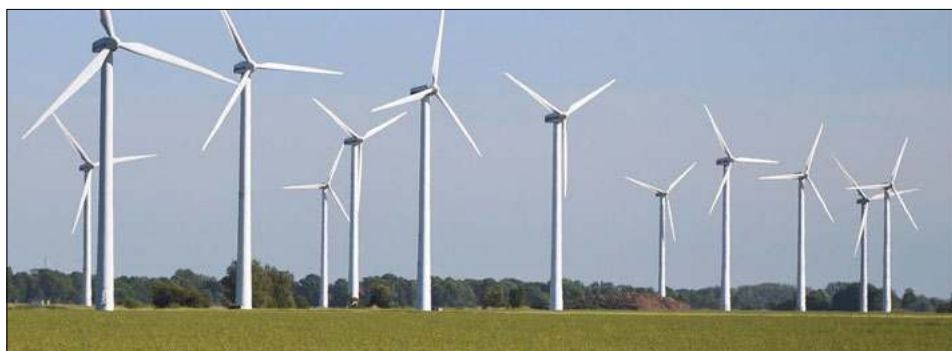
W Horodyszczu stanie 12 turbin wiatrowych, każda o mocy 2,5 megawata
