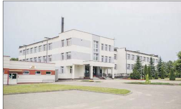
– Przeprowadziliśmy termomodernizację Zespołu Placówek Oświatowych w Leśnej Podlaskiej, m.in. ociepiliśmy elewację, wymieniliśmy stolarkę okienną i drzwiową – wymienia wójt Piotr Kazimierski
