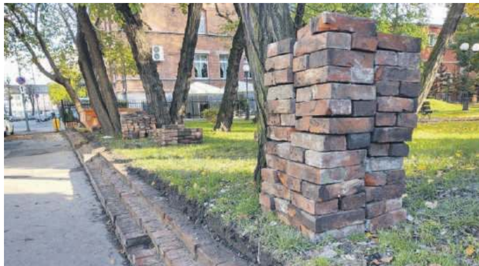
Murek będzie odtworzony z tej samej cegły
