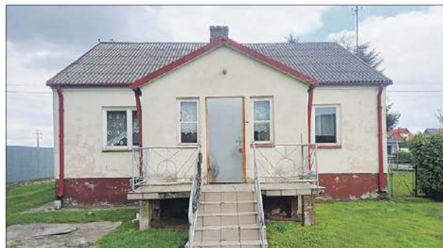
– Zamiast pomóc rodzinie przetrwać, zapewnić dach nad głową, to idzie się na łatwiznę i odbiera dzieci. Konsekwencje licytacji domu będą przerażające – mówi Piotr Ikonowicz. Na zdjęciu dom rodziny Łucyków
