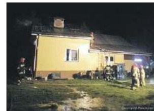
Prawdopodobną przyczyną pożaru było zwarcie instalacji elektrycznej
