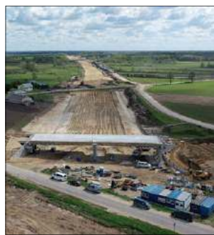
Zaawansowane prace trwają natomiast na odcinku autostrady A2 Swory – Biała Podlaska, tutaj wykonawcą jest firma Polaqua
