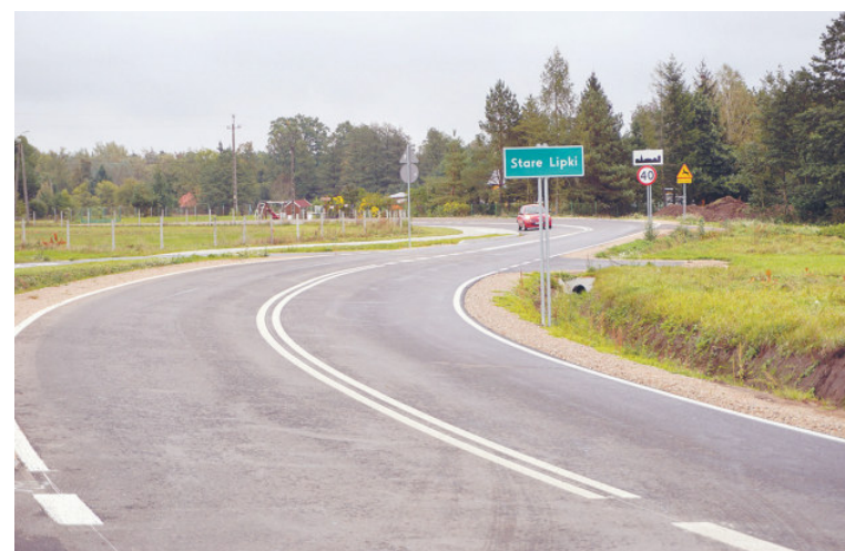
Przebudowana droga powiatowa Stoczek-Stare Lipki
