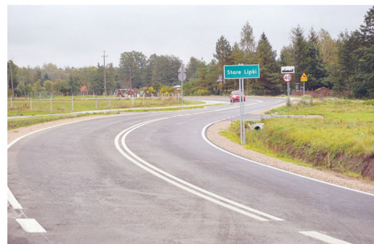
Przebudowana droga powiatowa Stoczek-Stare Lipki
