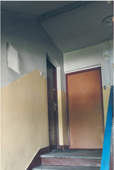
Osmalona dymem klatka schodowa fot. KO
