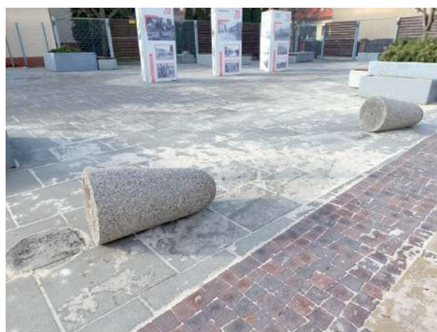
Ustawione na chodniku betonowe słupki zostały powyrwane
