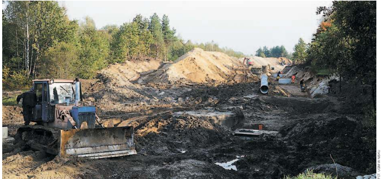
W tegorocznym budżecie władze Niska zabezpieczyły pieniądze na kontynuację rozpoczętej latem budowy łącznika do obwodnicy Niska i Stalowej Woli
