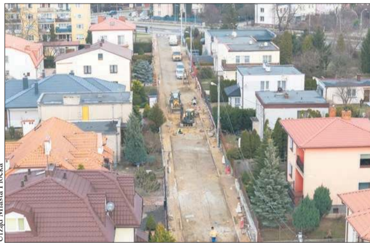
Prace na ulicy Małej na osiedlu Skarpa
