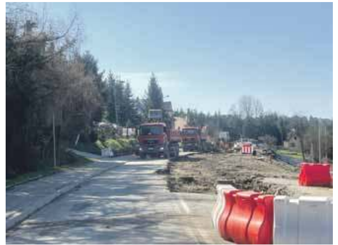
Remont osuwiska w ciągu ulicy Zakopiańskiej.
