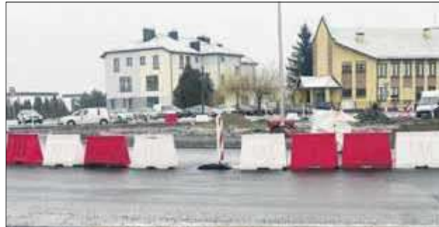
Budowane w ciągu ul. Janowskiej rondo będzie nosić nazwę Podlaskiej Wytwórni Samolotów
