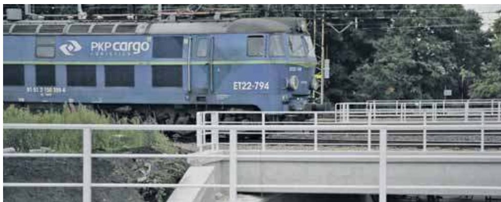
W 2018 r. zakończono remont wiaduktu przy ul. Częstochowskiej w Tarnowskich Górach. Ma kluczowe znaczenie, gdyż tędy będą przejeżdżać pociągi szybkiej kolei na lotnisko
