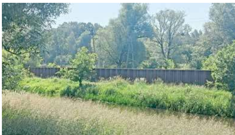
Konstrukcja została wybudowana na drugim brzegu rzeki
