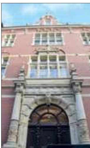
Fragment elewacji z głównym wejściem do budynku po remoncie
