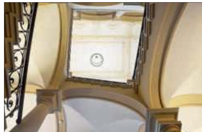
Widok na klatkę schodową
