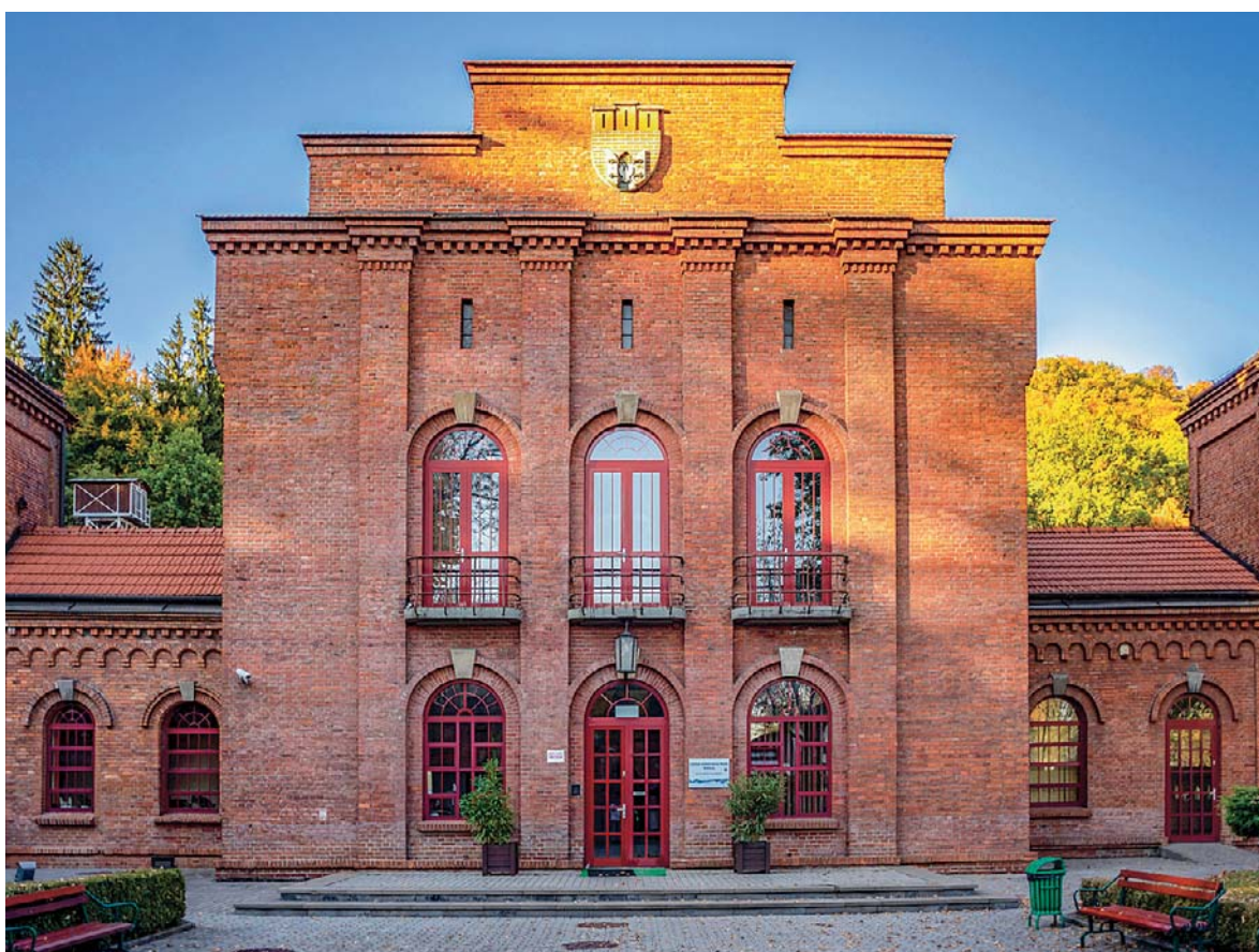
FOT. WODOCIĄGI MIASTA KRAKOWA
