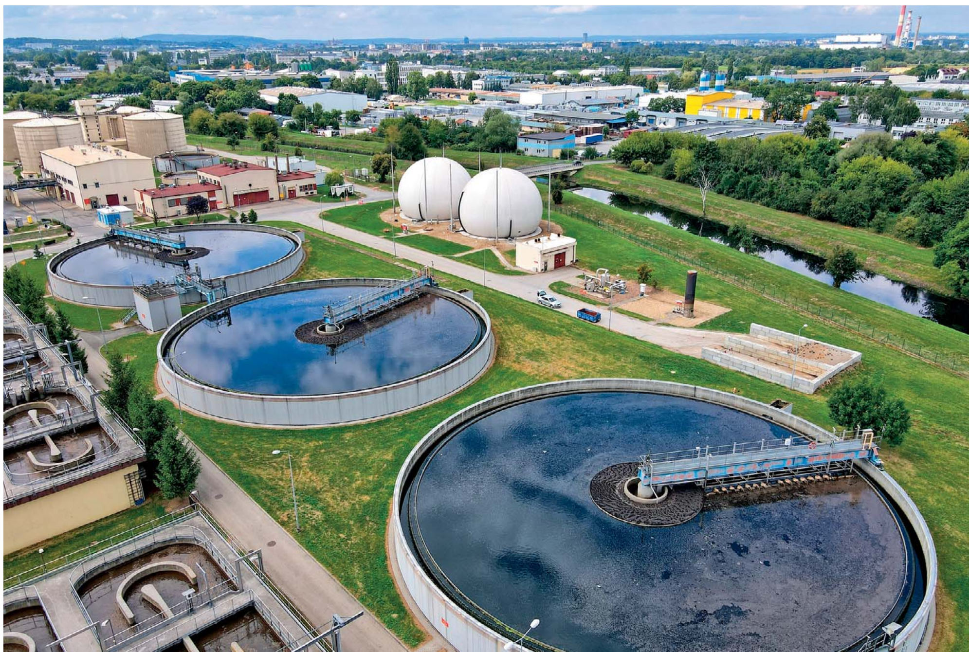
FOT. WODOCIĄGI MIASTA KRAKOWA
