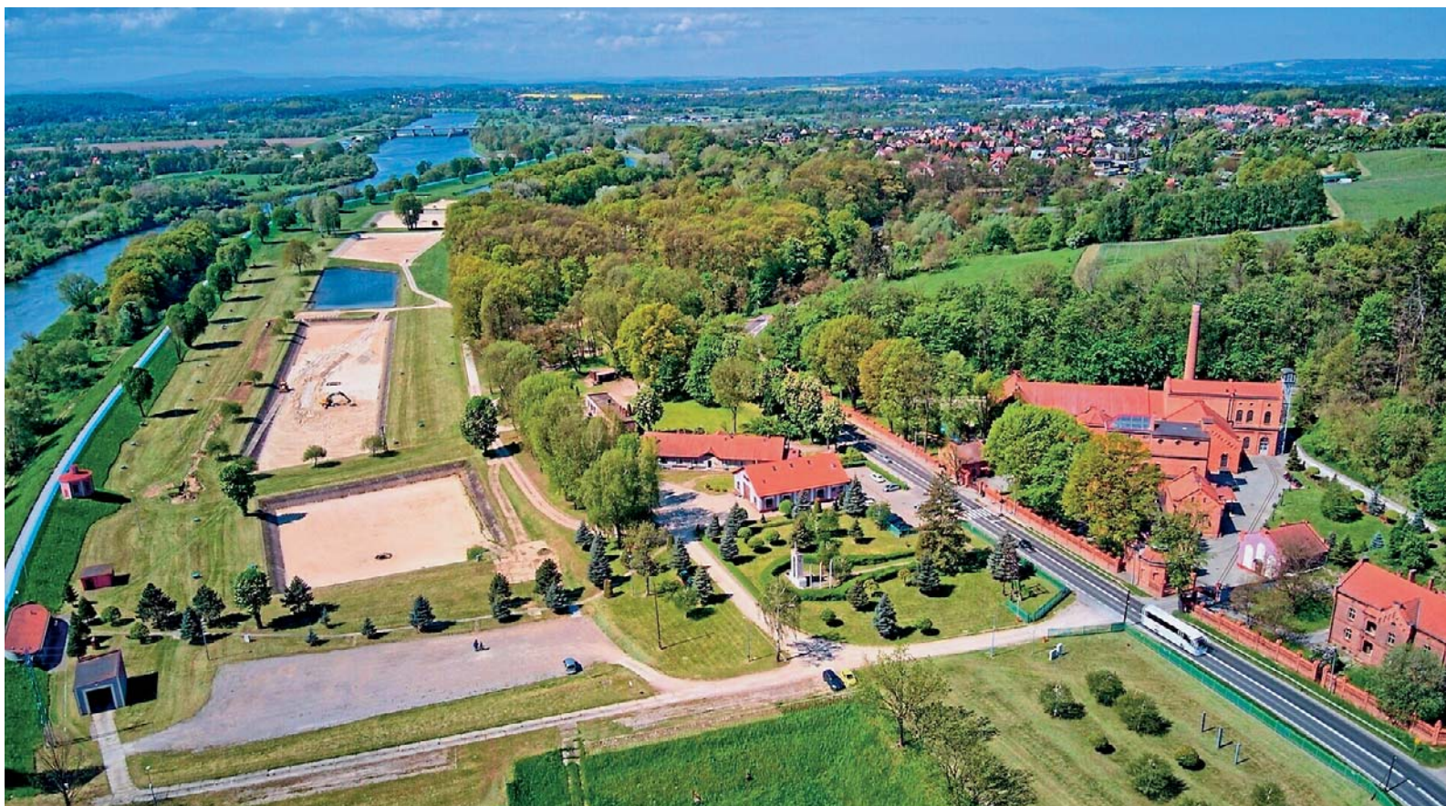
FOT. WODOCIĄGI MIASTA KRAKOWA
