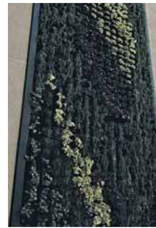
Zielona ściana Chorzowskiego Centrum Kultury
