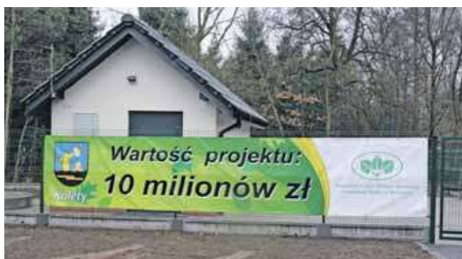
Podczas budowy kanalizacji w Miotku, która zakończyła się jesienią 2019 r., wybudowano stację podciśnieniową, przygotowaną do obsługi Zielonej
