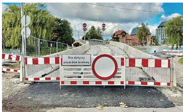
Tymczasowa przeprawa przez rzekę Elbląg
