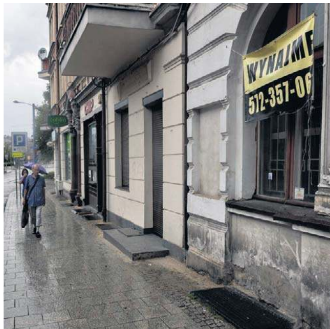
„Chorzów umierał, a w tej chwili jest już totalna kłapa” – usłyszeliśmy pod estakadą
